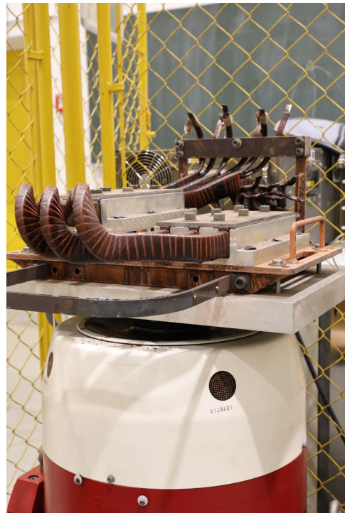
Detailansicht bei der mechan. Konditionierung
