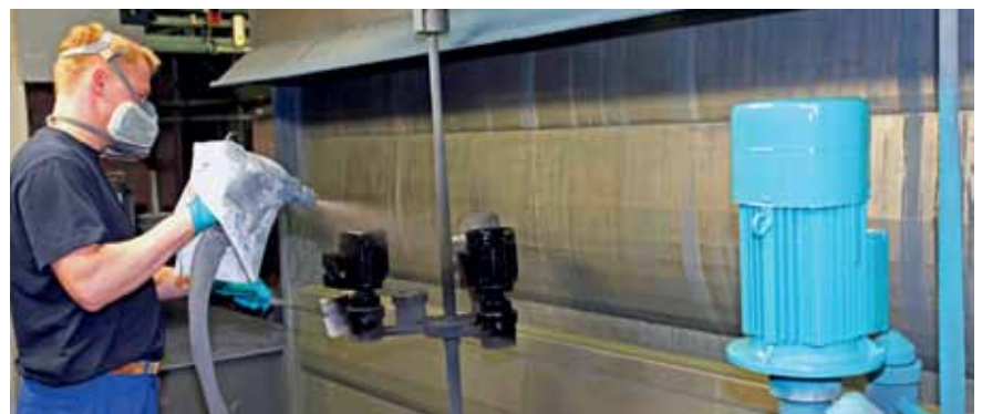
Marcus Moll in der Zwickauer Farbspritzanlage. In der neu geplanten Anlage kommen permanent-erregte Synchronmotoren zum Einsatz.
