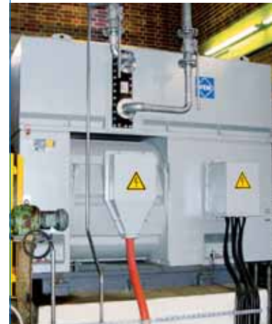
Slipring motor for SO 2 fan drives, type DBKAJ 6321-4WF, 2050 kW, 6 kV
